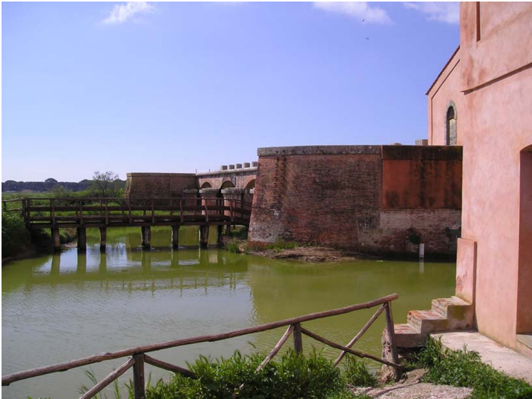
I contrafforti e il sistema per colmata della “Casa Rossa” (Foto P.Ceccuzzi)
