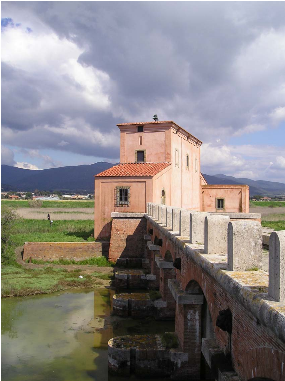
La “Casa Rossa: il sistema delle cateratte. Si intravedono gli alloggiamenti per le paratie. (Foto P.Ceccuzzi)
